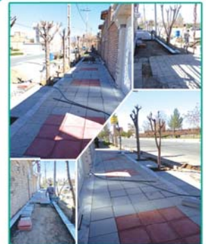
عملیات کفسازی و موزائیک فرش معارض سطح شهر
